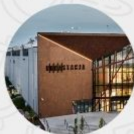
Nowa Stacja /Pruszków/
